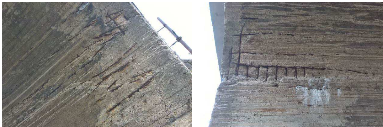
Nepravidelné uložení třmínků a odpadlá krycí vrstva od provozu kamionové dopravy.
